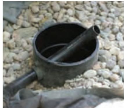
de las pompas. Use un serrucho para cortar la salida del codo más alto.
