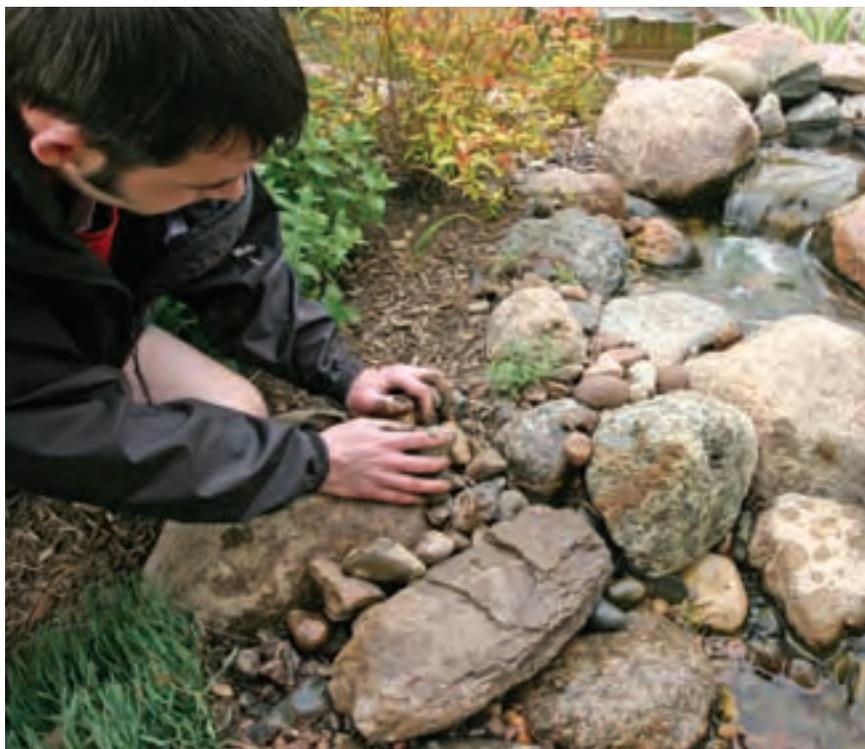
• Si la catarata tiene razón lejos el lado de el estanque, o sólo 5' espalda de el estanque, el método más eficiente deberá quitar las piedras y el grava en el área del catarata y la búsqueda para el escape a mano y el ojo. El escape, una vez que encontró, puede ser fijado fácilmente usando cinta de remiendo de Aquascape EPDM.
